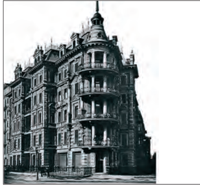
Nach der Fertigstellung 1890 ohne Lokal
