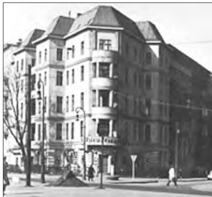
Kriegsschäden: Türmchen und Stuck sind weg
